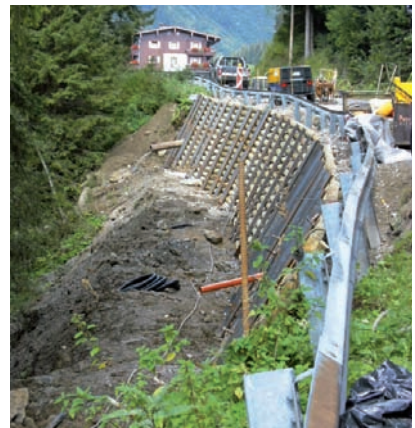
Errichtung einer rückverankerten Holzstützwand
