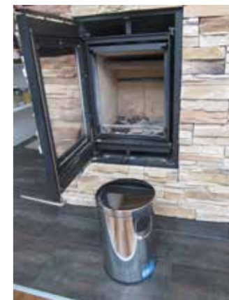
Aschenabfälle dürfen nur in Metallbehältern gelagert werden
