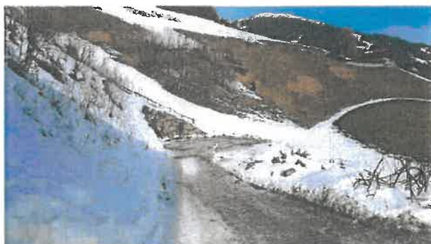
Abb. 2: Zufahrtsstraße und Wendeplatz liegen derzeit als Rohplanum vor
