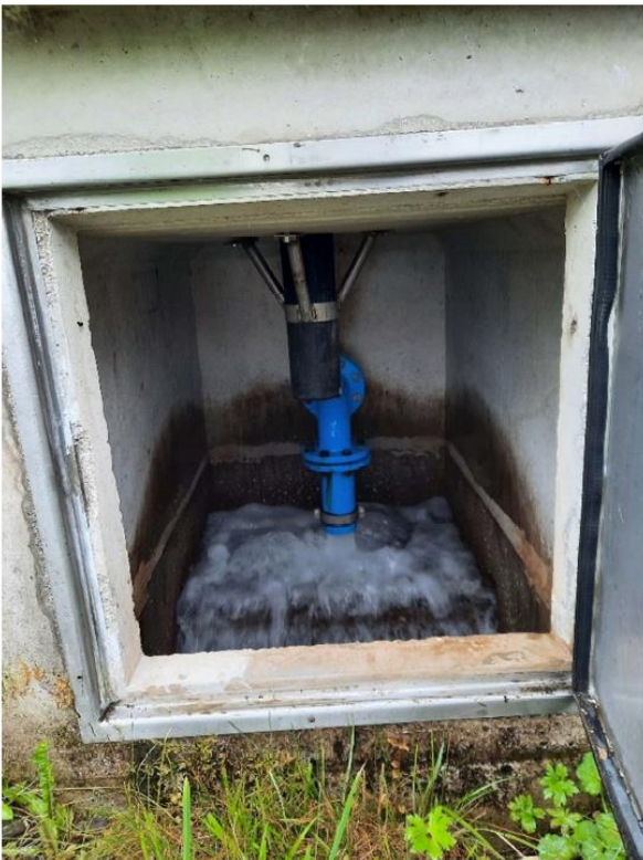
Abbildung 8: Unterbrecherschacht 4 und neue Überlaufleitung inkl. Froschklappe.
